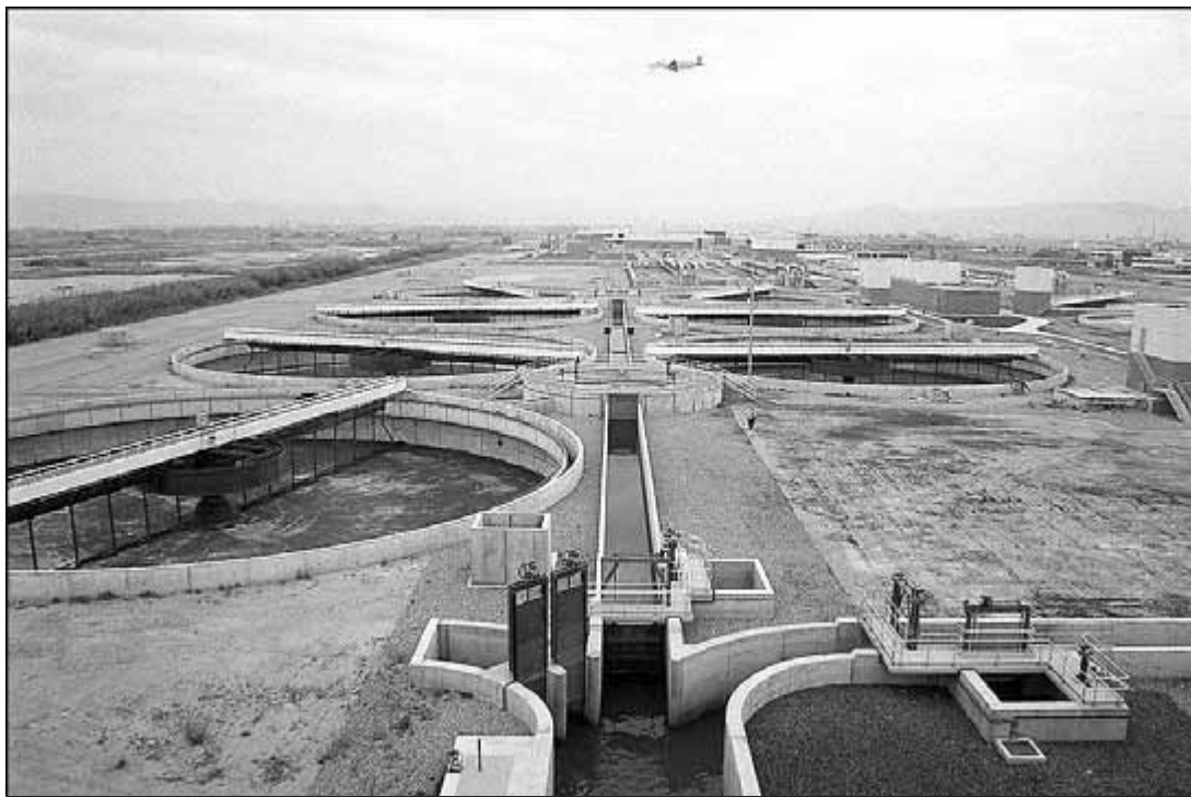
La depuradora del Llobregat ha costat 260 milions d'euros
